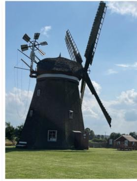
Der achteckige Erdholländer mit drei Fachwerkgeschossen ist mit über 250 Jahren (Baujahr 1752) eine der ältesten Erdholländer-Windmühlen des Bundeslandes. Als nach wiederholten Sturmschäden 1955 kein Windbetrieb mehr möglich war, wurde ein Elektromotor eingebaut. Zwischenzeitlich war die bis 1948 im angrenzenden Wohnhaus betriebene Bäckerei stillgelegt worden.
