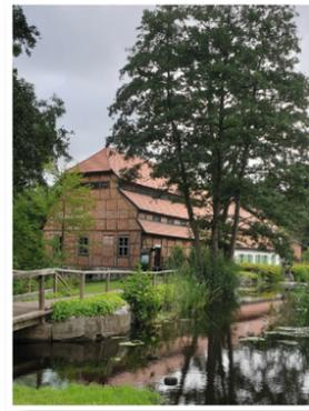
Die Wassermühle Hanshagen: 1524 als klösterliche Kornmühle erbaut; wurde 1534 nach der Reformation herzoglich. Eigentum; gelangte 1654 durch schwedisches Edikt in Besitz der Univ. Greifswald; 1750 Umbau zur Papiermühle, Papierproduktion bis Entdeckung von Holzschliff und Zellulose; 1855 Rückbau zur Kornmühle, genutzt bis 1952; Verfall; 2010 - 2012 komplette Restaurierung; Heute: Vollfunktionsfähige Kornmühle; Technisches Museum; Museale Information zur Papierproduktion von 1750 - 1850.
